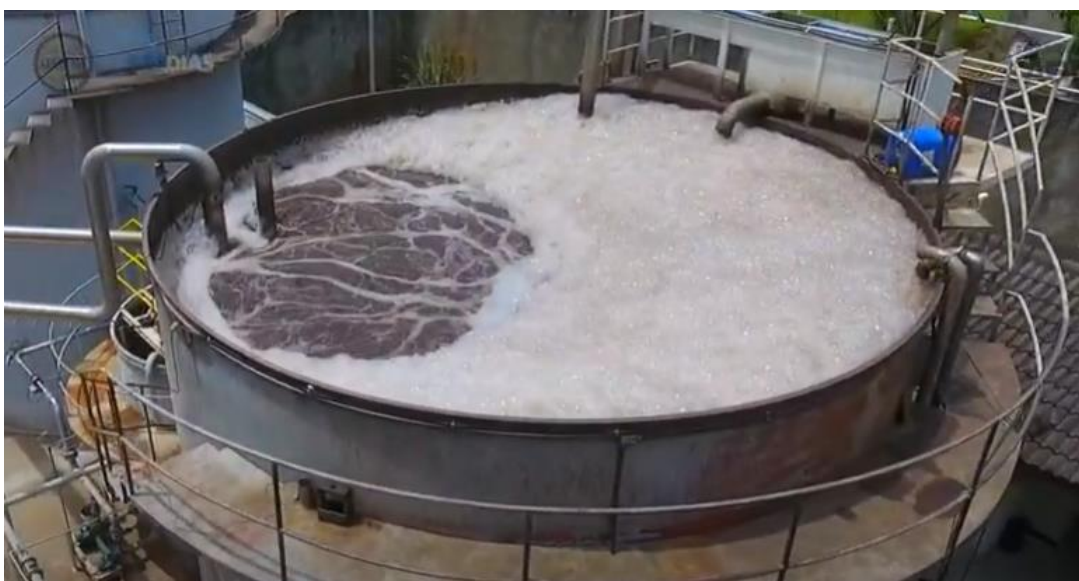
Figura 2. Tratamento de efluentes da Cervejaria Germânia com Biorreator à Membrana
