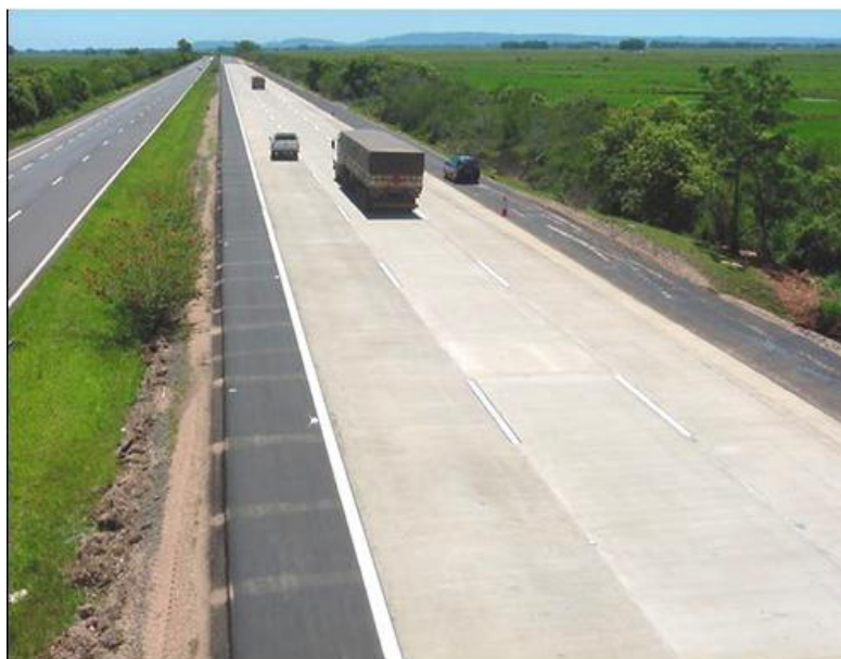
Figura 12 – BR 209 em Porto Alegre, realizada com a técnica de Whitetopping
