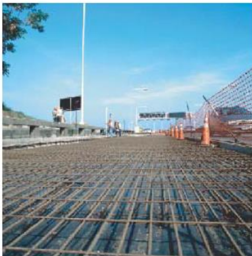
Figura 10 – Pavimentos de Concreto Armado.
