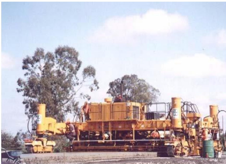
Figura 7 – Vibroacabadora de fôrmas deslizantes.
