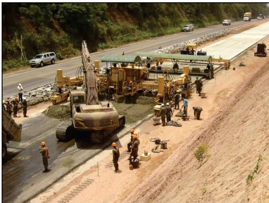
Figura 6 – Pavimentação em concreto em trecho na Rodovia BR 101/NE.
